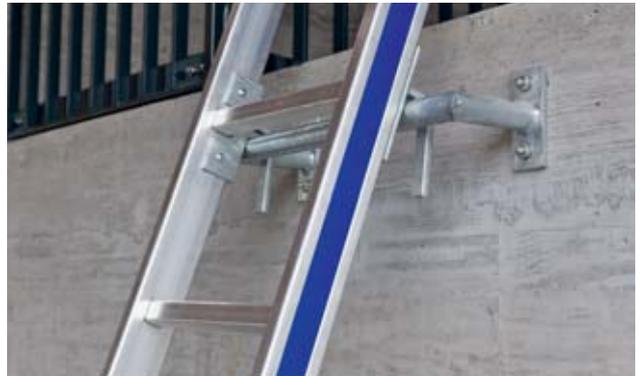
Fig. 27: dispositif d'accrochage
