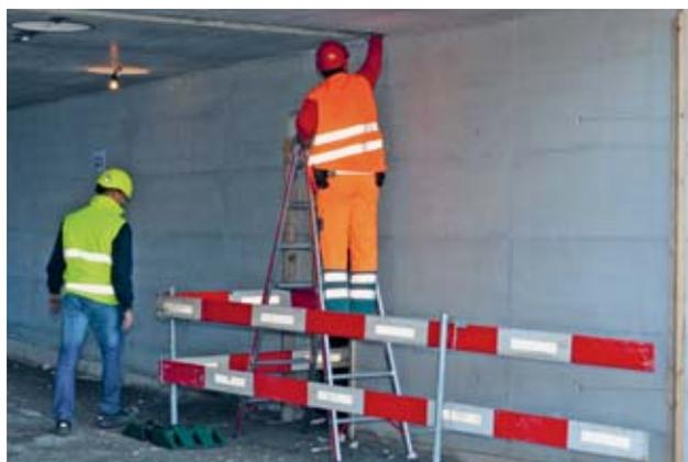
Fig. 3: sécurisation des échelles dans un passage
