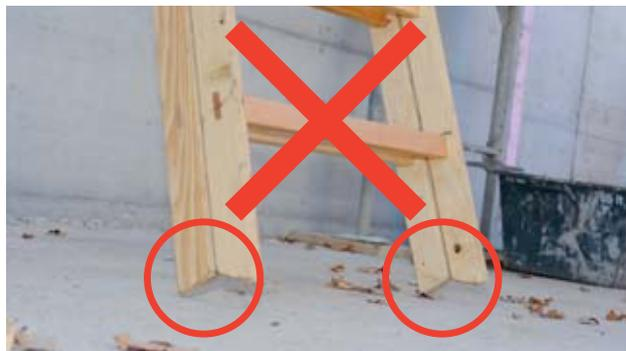
Fig. 39: échelle double utilisée comme échelle simple; elle repose uniquement sur le bord du pied.
