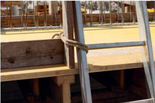
Fig. 25: fixation avec une corde
