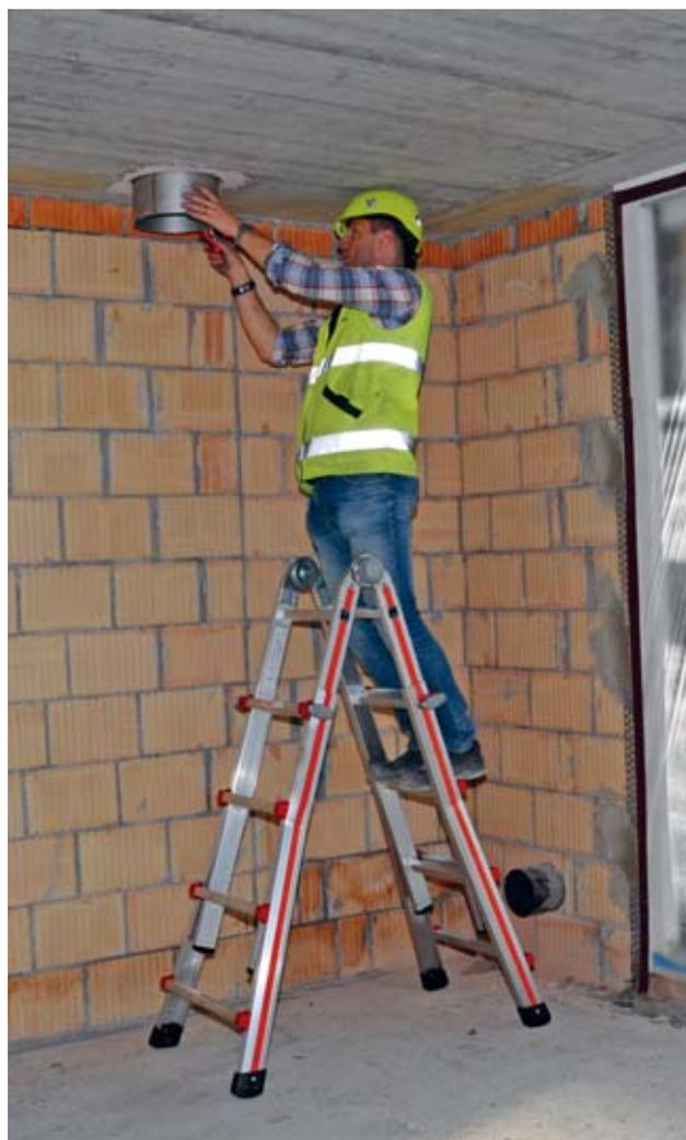
Fig. 50: échelle combinée: utilisable comme échelle simple, échelle double et échelle double pour escaliers
