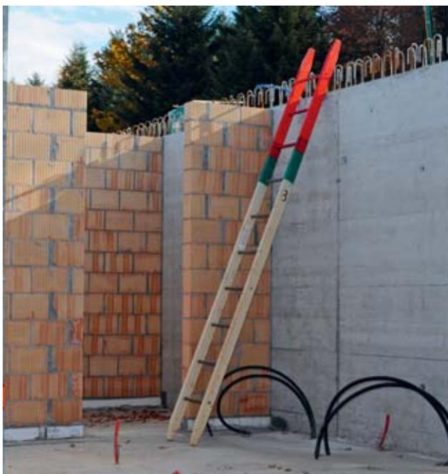
Fig. 13: échelle simple; les trois derniers échelons ne doivent pas être gravis.
