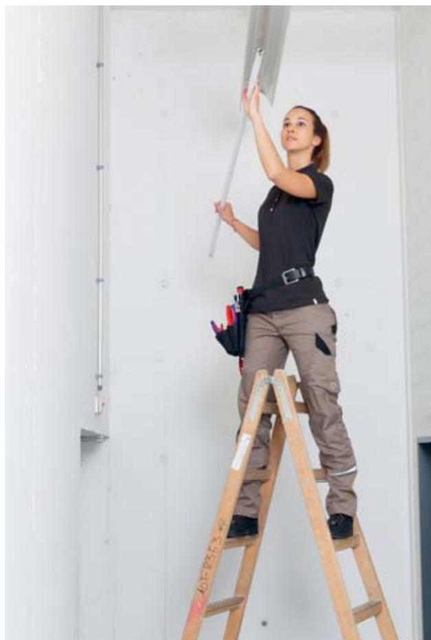
Fig. 42: les deux derniers échelons servent uniquement à se stabiliser
