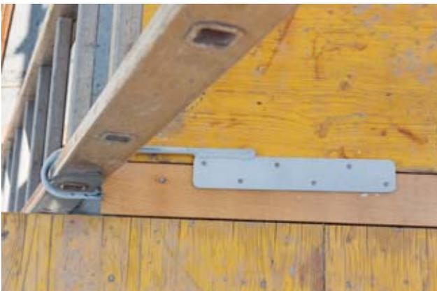
Fig. 26: sommet sécurisé par un crochet
