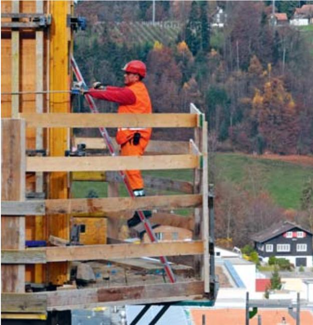
Fig. 4: mesure de protection supplémentaire (protection latérale haute) en cas de zone à risque de chute accru
