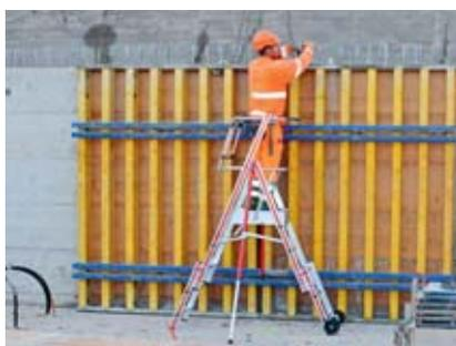
Fig. 5: échelle avec plate-forme
