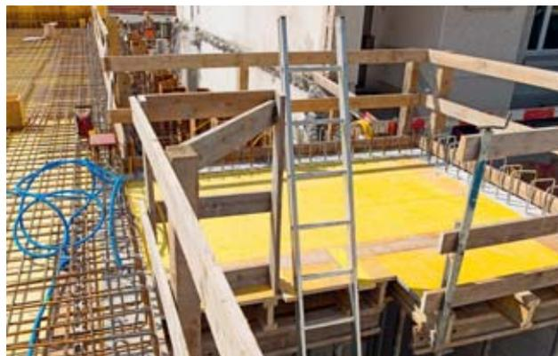
Fig. 14: l'échelle dépasse d'au moins 1 m le point d'appui supérieur.
