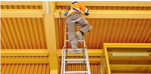
Fig. 33: personne sur une échelle assurée par une protection par encordement, point d'ancrage au-dessus de la tête
