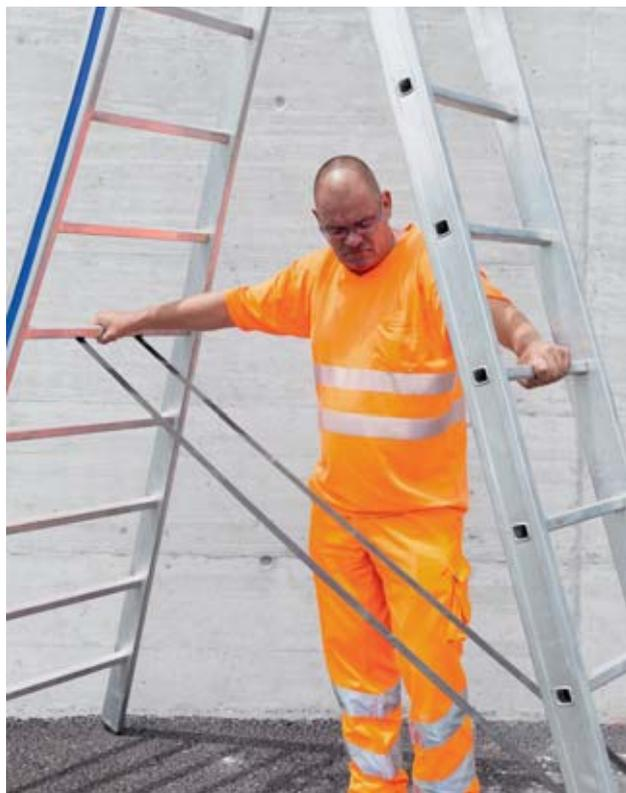
Fig. 40: mise en place des dispositifs de sécurité contre l'écartement
