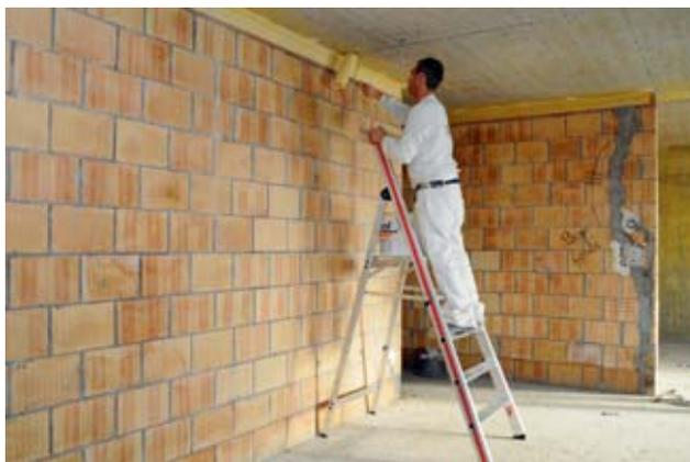
Fig. 47: échelle double à marches avec plate-forme et dispositif de retenue
