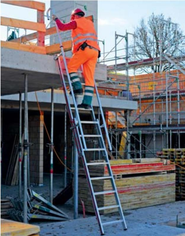
Fig. 16: montants de l'échelle rallongés pour garantir la sécurité de l'utilisateur
