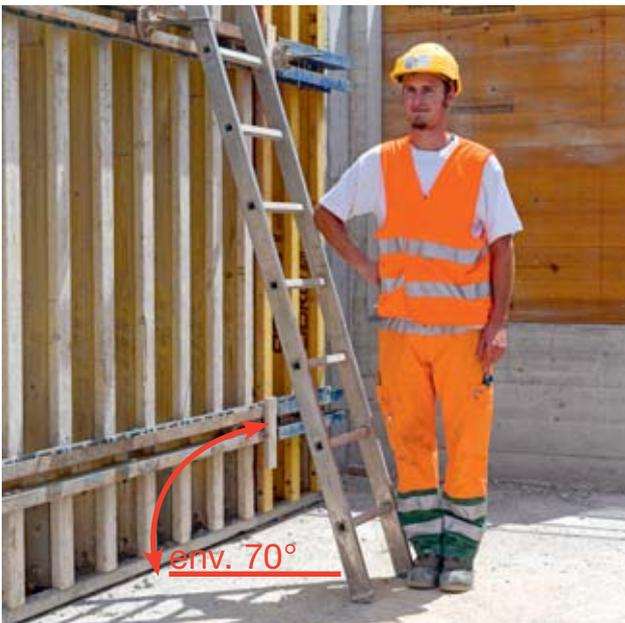
Fig. 17: vérification de l'angle grâce au test du coude
