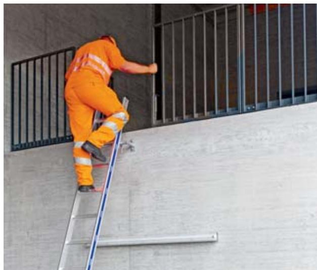
Fig. 15: dispositif de retenue, garde-corps près de la zone à risque de chute et sommet de l'échelle sécurisé
