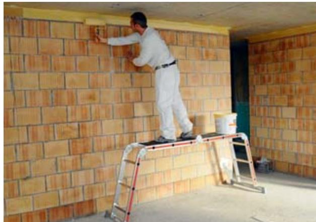
Fig. 49: échelle transformable, également utilisable comme plate-forme de travail
