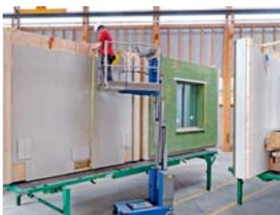
Fig. 6: plate-forme élévatrice mobile de personnel à déplacement vertical
